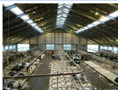
View fra platformen i kostalden
