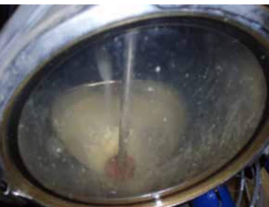
Mælkerester i pumpebrønd
