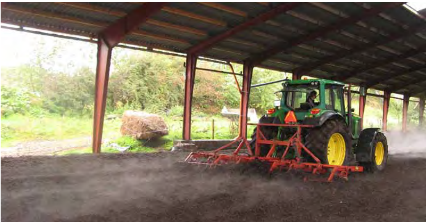
Daglig harvning fremmer komposteringsprocesserne ved at tilføre ilt til materialet.
