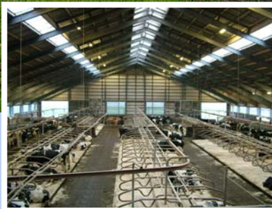
View fra platformen i kostalden
